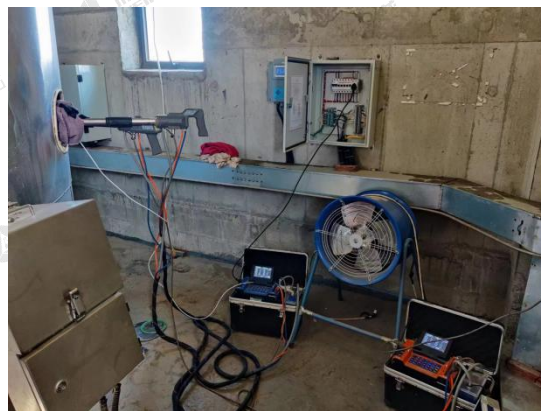
◎有组织废气采样点 - 2#废气排放口
