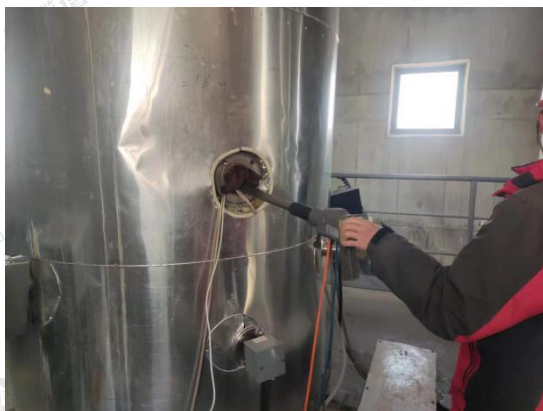
◎有组织废气采样点 - 1#废气排放口
