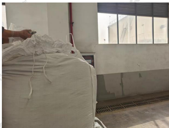
■ 固体废物采样点 - 飞灰暂存间
